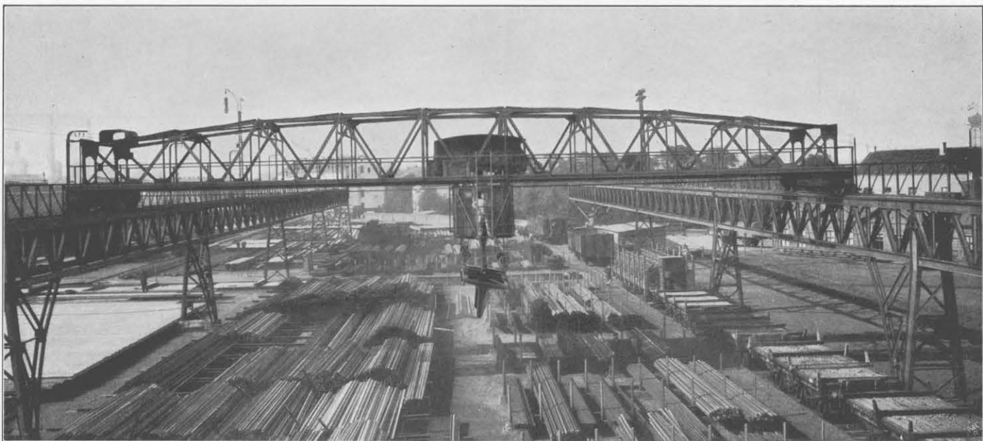
Figur 88. Grubenschienenlager mit Verladekran.
