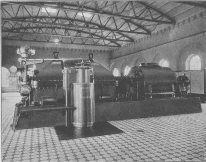
Abdampf-Turbodynamo von 1600 KW.
